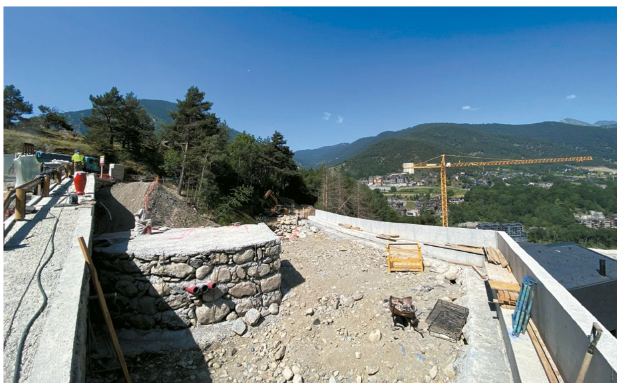
Treballs de construcció del nou pàrquing d'Anyós
