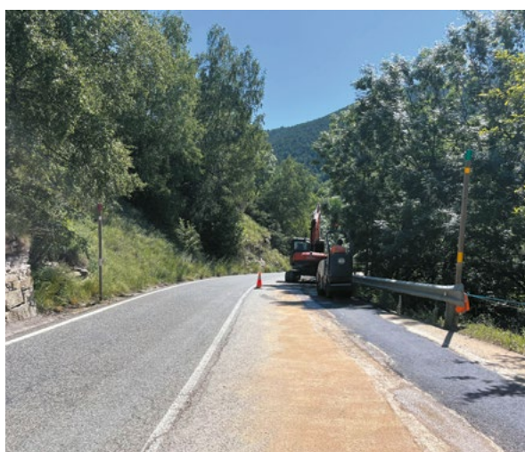
Treballs de millora dels col·lectors
