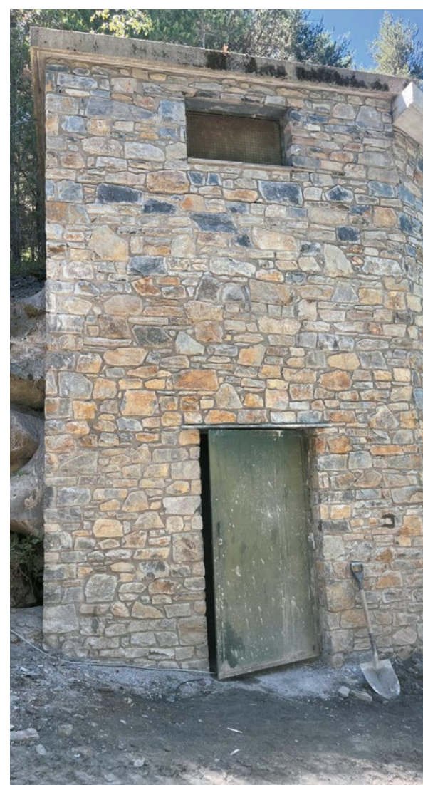
Dipòsit d'Anyós, gestionat telemàticament
